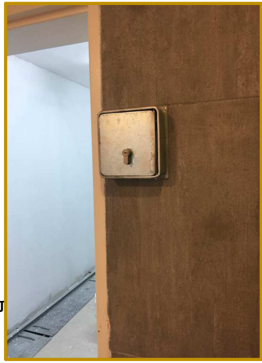
התקנת קופסה להכנסת מפתח עבור קורא מונים לחדר מונים
