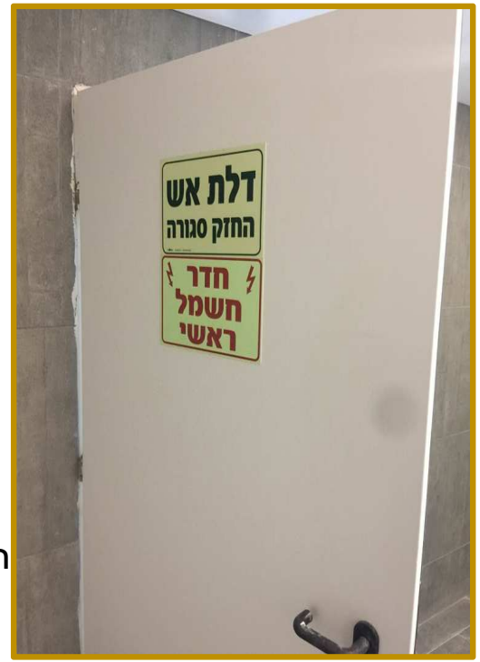
חדר חשמל ראשי חייב להיות בעל דלת מוגנת אש פתיחה החוצה
