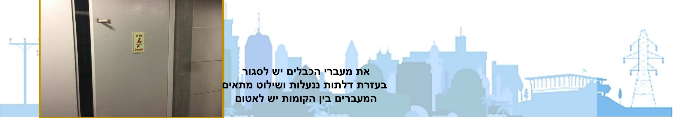
חדר חשמל ראשי חייב להיות בעל דלת מוגנת אש פתיחה החוצה
