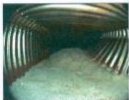
T27 סרימת בטון דרך חופן התעלה והתחמשת רחל הסת. קרחיה ברזל גסס
